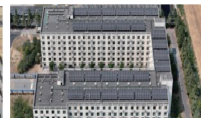
钱营孜煤矿-职工宿舍光伏
