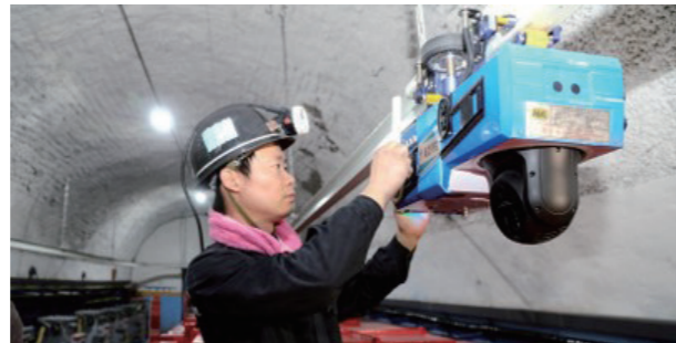
钱营孜煤矿作业现场
